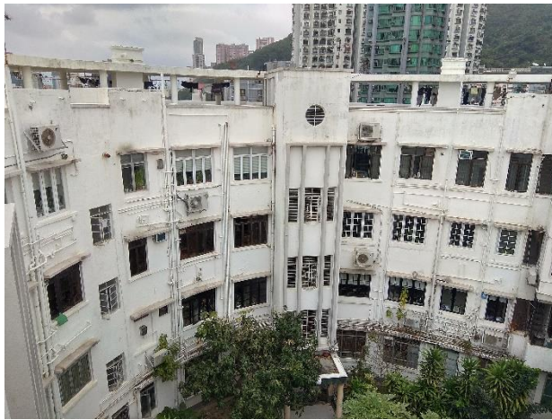
照片 01 樓宇背面立面
