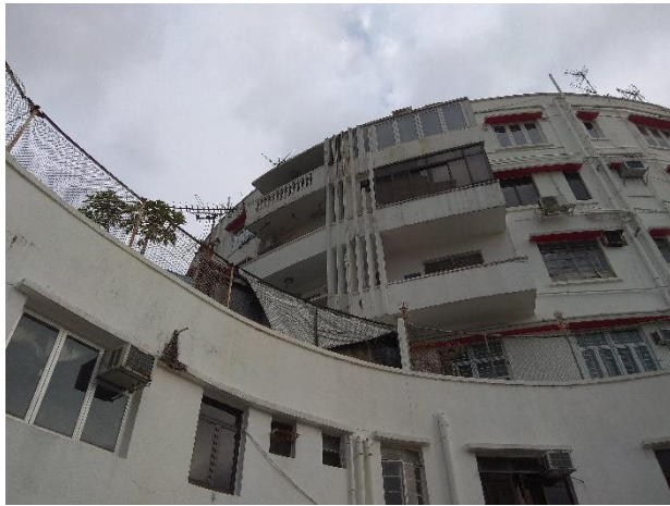
照片 02 樓宇正立面
