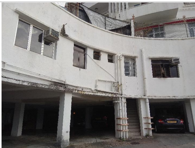
照片 03 樓宇側立面
